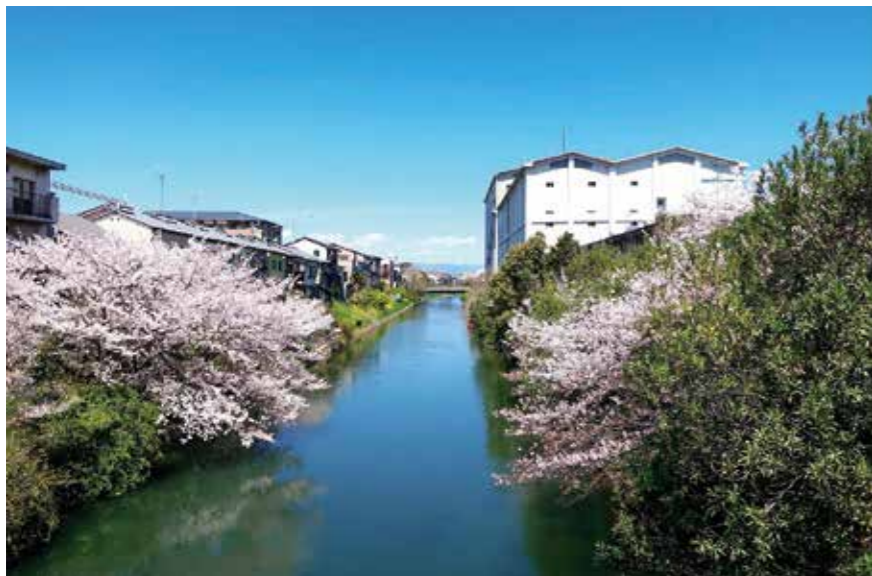
上／惜しくも2014年に解体された月桂冠北蔵の明治期蔵。下／右手奥が月桂冠の鉄筋コンクリート造貯蔵庫
