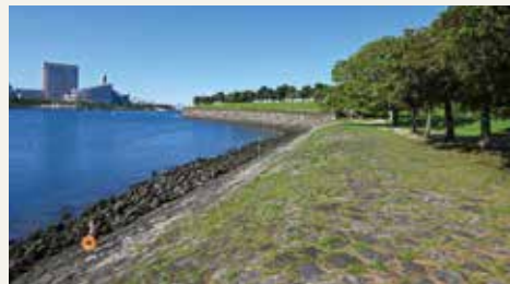
現在は公園となっている「第三台場」。護岸部の石垣やその上に盛られた土塁はそのまま残っている。江戸時代のすぐれた土木技術を現在に伝える、貴重な土木遺産である
