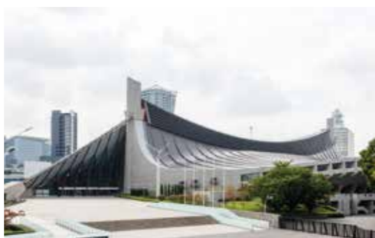
丹下健三が設計した国立代々木競技場。世界で初めて鉄骨を構造材に用いるなど、構造とデザインがハイレベルに融合している（撮影：山田新治郎）
