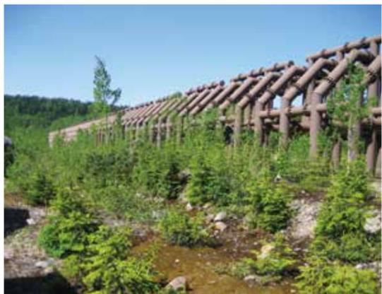
上/コンクリート型の砂防堰堤。下/鋼製の砂防堰堤
