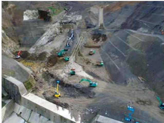
左／重機のARカメラがコンクリートブロックの背面にあるARマーカを読み取ることで設置位置を割り出し、重機に搭載された人工筋肉ロボットが重機を操作することで、コンクリートブロックの把持から設置までの一連の作業を自動化した
