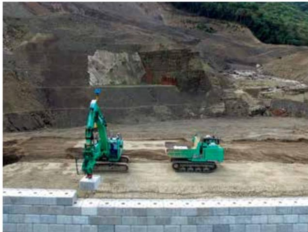
右／出水期の掘削・土砂運搬は遠隔操作による無人化施工で実施された。最盛期には最大15台の重機が活躍した
