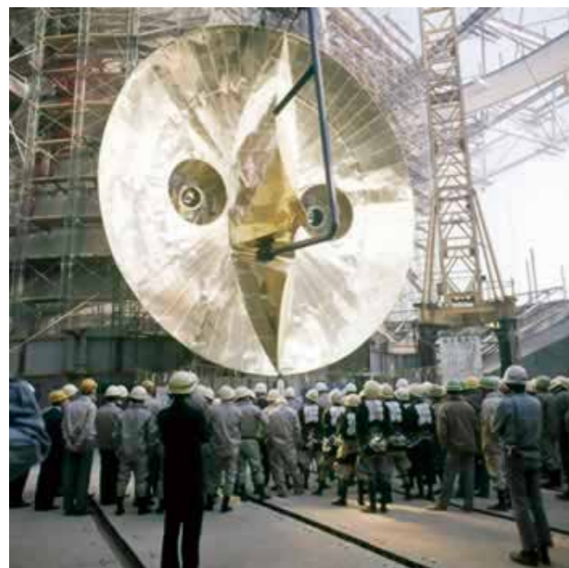
建設中の太陽の塔
