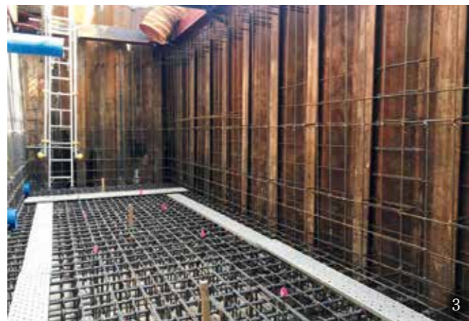
1. プレキャスト柱の建て起こし状況 2. J-WALL II 鋼矢板の断面ディテール 3. J-WALL II 床版・壁鉄筋組立状況
