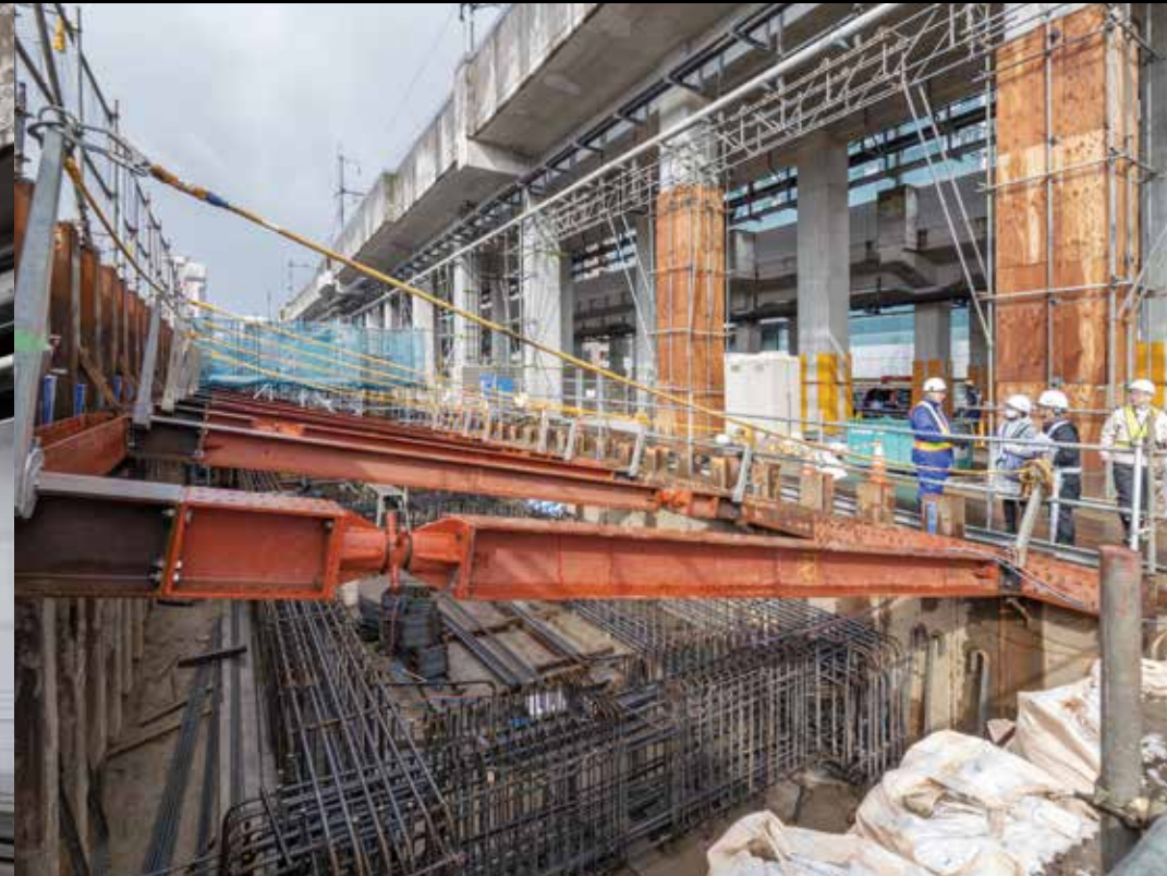
千歳工区で施工中の橋脚基礎。写真右に見えるのは北陸新幹線の高架橋で、富山地鉄の工事中は橋脚を損傷させないためにコンパネで防護している
