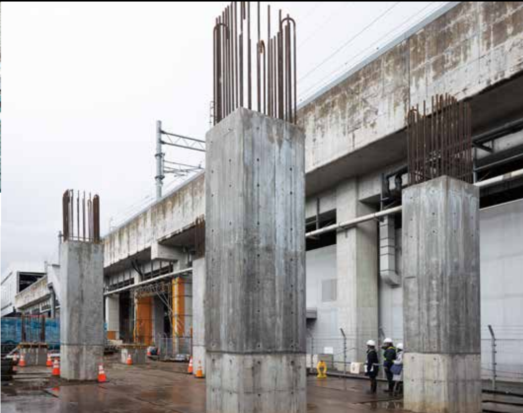
電鉄富山駅工区で建設中の高架橋の柱部。写真左奥に見えているのは北陸新幹線・富山駅の駅舎
