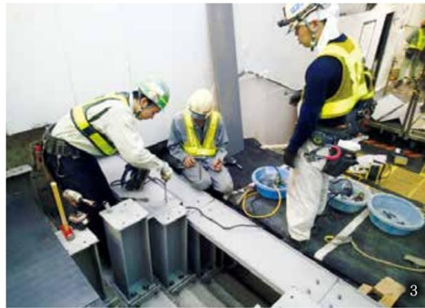
1. 移設管の発進側 2. 既存階段の撤去の様子 3. 踏面プレート設置の様子
