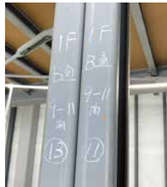
資材を再利用できるように部材に番号を付けて管理
