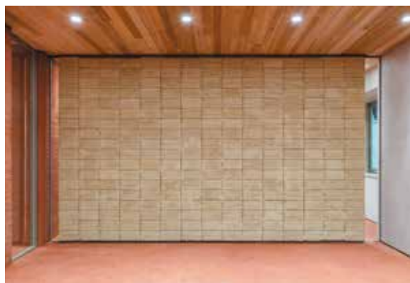
浅沼組技術研究所が開発した「還土ブロック」を使った界壁
