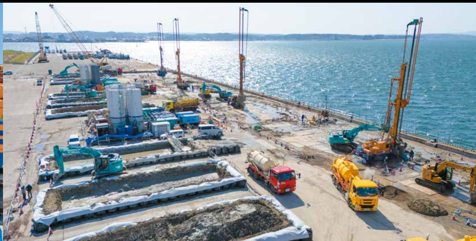
地盤改良機の後ろは工事車両が行き交い、大量に発生する排泥を溜める巨大なピットが設けられている。排泥を段階的に乾燥させるため、ピットからピットへ重機で移し替える作業が続く
