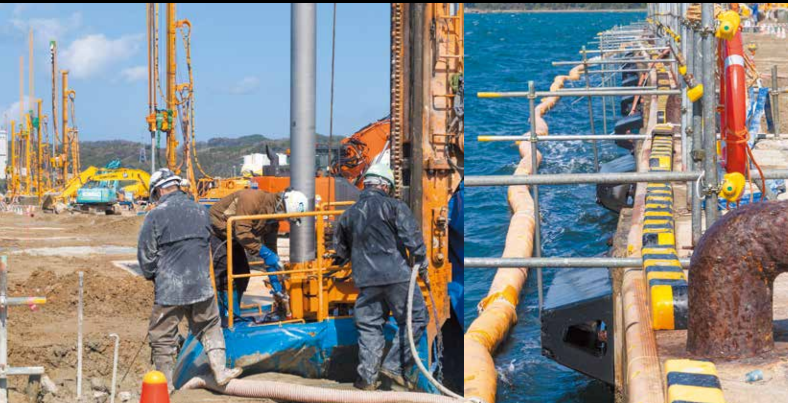
柱状の地盤改良機。細長いロッドを地中に挿し込み、セメントスラリーを噴射する
