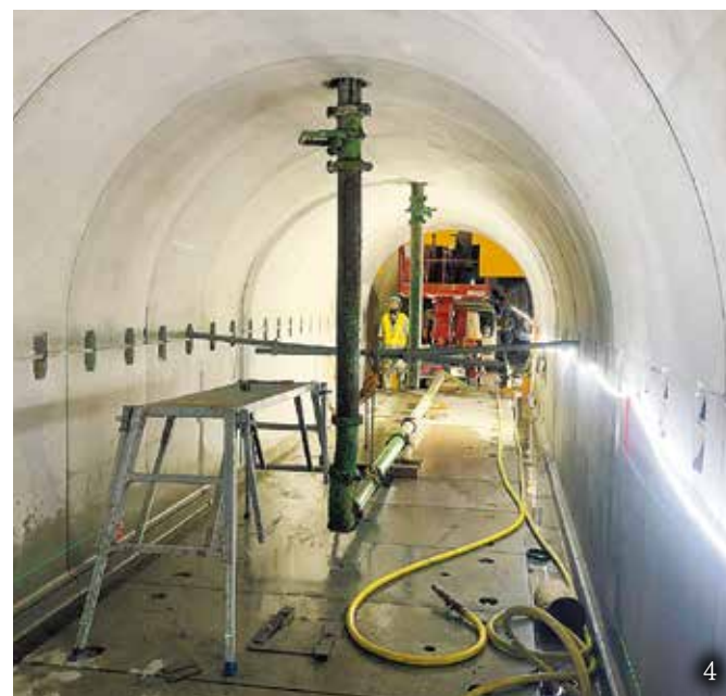
1. 打設最盛期の施工状況 2. プレキャスト型枠 3. 妻側エキスパンドメタル・止水版内側ステンレス板 4. 側部と頂部用打設孔
