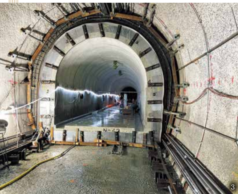
1. 打設最盛期の施工状況 2. プレキャスト型枠 3. 妻側エキスパンドメタル・止水版内側ステンレス板 4. 側部と頂部用打設孔
