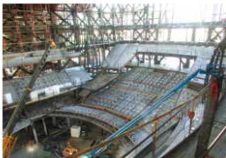
工事施工図の確認や施工現場での音響関連工事の指導、設備機器の検査・測定
