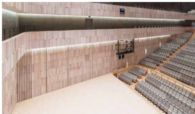
壁面の下部は自然木のパネルをランダムに配置し広がりのある音響を目指した。理想的な反射音をつくるために木パネルには化粧ガラスウールを施した。「パネルの配置、形状が響きに大きく影響することになります。豊かな音をつくるために詳細に検討しました」(郷野氏)
