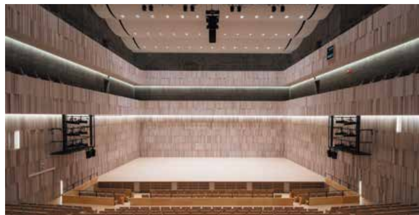
ホールの形状は長方形の一边をステージとし音響効果を優先したエンドステージ型だが、舞台幕を設置して舞台を額縁のように切り取るプロセニアム型(下)にも転換できる。双方の型式で最良の響きを生み出すため、音響反射板の構造や可動式天井の収納などについて検証と議論が繰り返された
