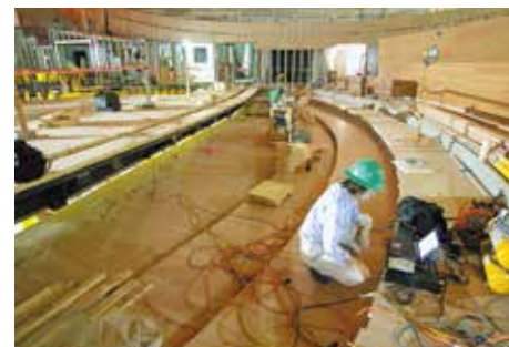
工事途中における音響確認測定
