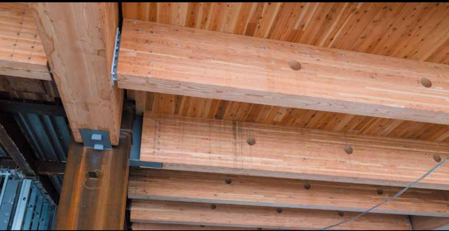
鉄骨柱に木造の梁が接合されている、本建築ならではの取り合い部。木材は、柱・梁には国産のカラマツ、床や外装には多摩産のスギが用いられている
