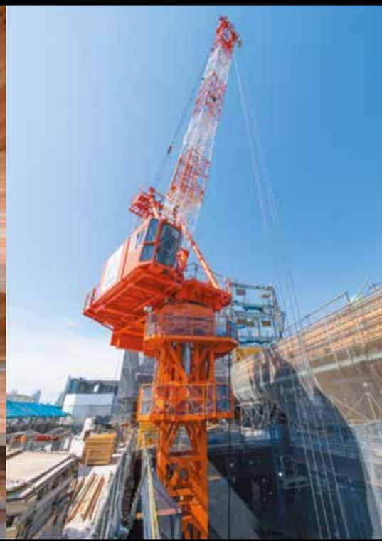
柱・梁の建方などに使用したタワークレーン。建物中央を後施工とし揚重用開口として利用している
