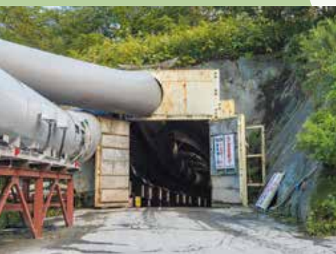
斜坑の入り口。ここから坑内に入り、終点側、起点側それぞれに向かって掘り進めた
