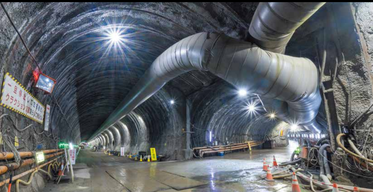
写真右奥からの斜坑と本坑との合流地点。左奥はトンネル起点側となる
