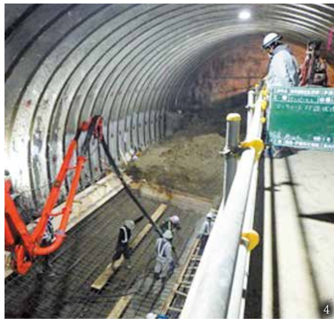
1. プロテクター設置状況（坑内） 2. プロテクター中央移動状況 3. 集塵機・遮音壁設置状況 4. 貫通前のインバート施工状況
