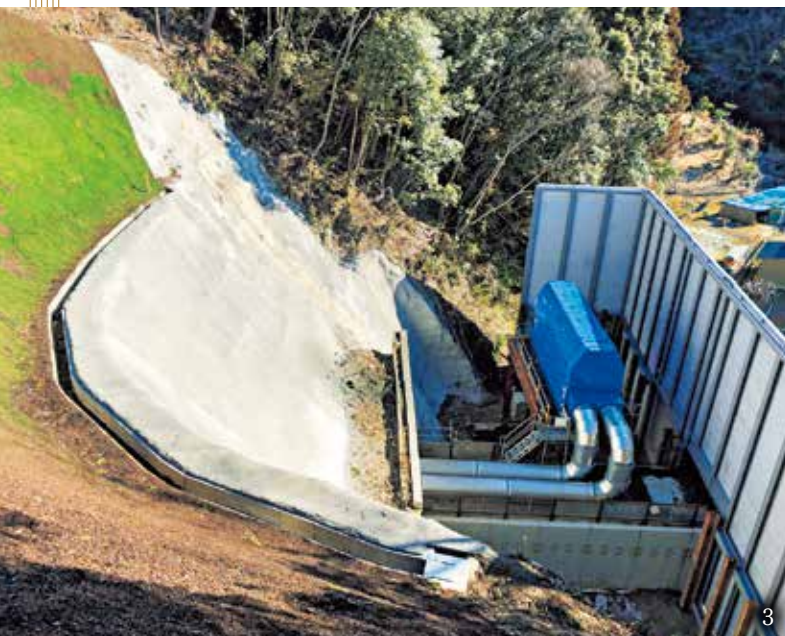
1. プロテクター設置状況（坑内） 2. プロテクター中央移動状況 3. 集塵機・遮音壁設置状況 4. 貫通前のインバート施工状況
