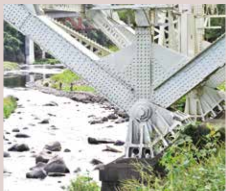
晩翠橋は右岸のたもとから河岸に降り立ち、その雄姿を間近に見上げることができる。アーチ部の基礎橋台が両岸に2基設けられている。これほど巨大な橋梁を両岸の橋台とこのアーチ橋台で強固に支えている。この地点からアーチリブに沿って対岸に視線を移していくとその姿の優美さが胸に迫ってくる
