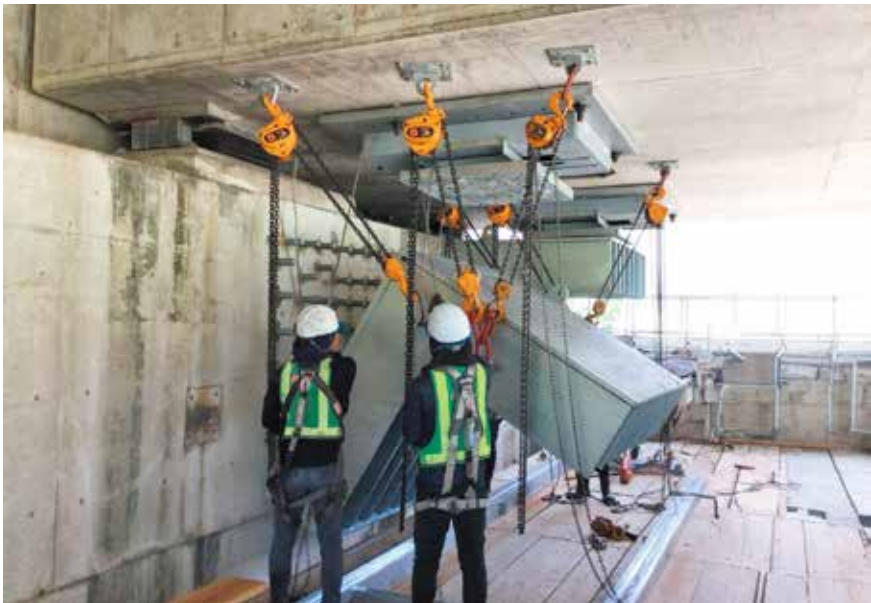
橋梁補修（落橋防止）の施工例
