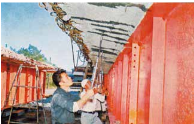
1964年 復旧工事におけるショーボンドグラウトSSの注入作業
