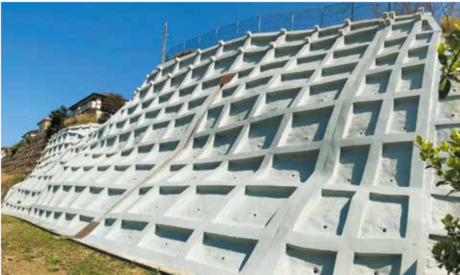
写真手前側の法面は施工済み箇所（奥側は未補修の既設吹付法枠が残る）
