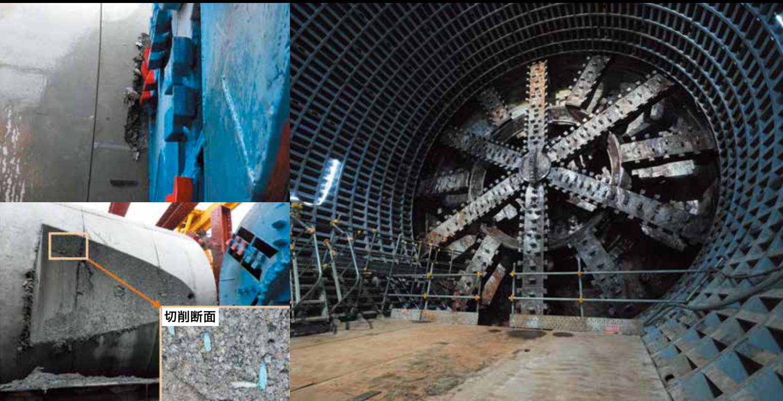
右／地中接合時の2号機到達状況。接合後に解体され、現在は接合部の内壁にその姿を残している（提供：西松建設㈱） 左上・左下／JVで共同開発した「切削セグメント」。鉄筋の代わりにFFU素材で補強されている（提供：西松建設㈱）
