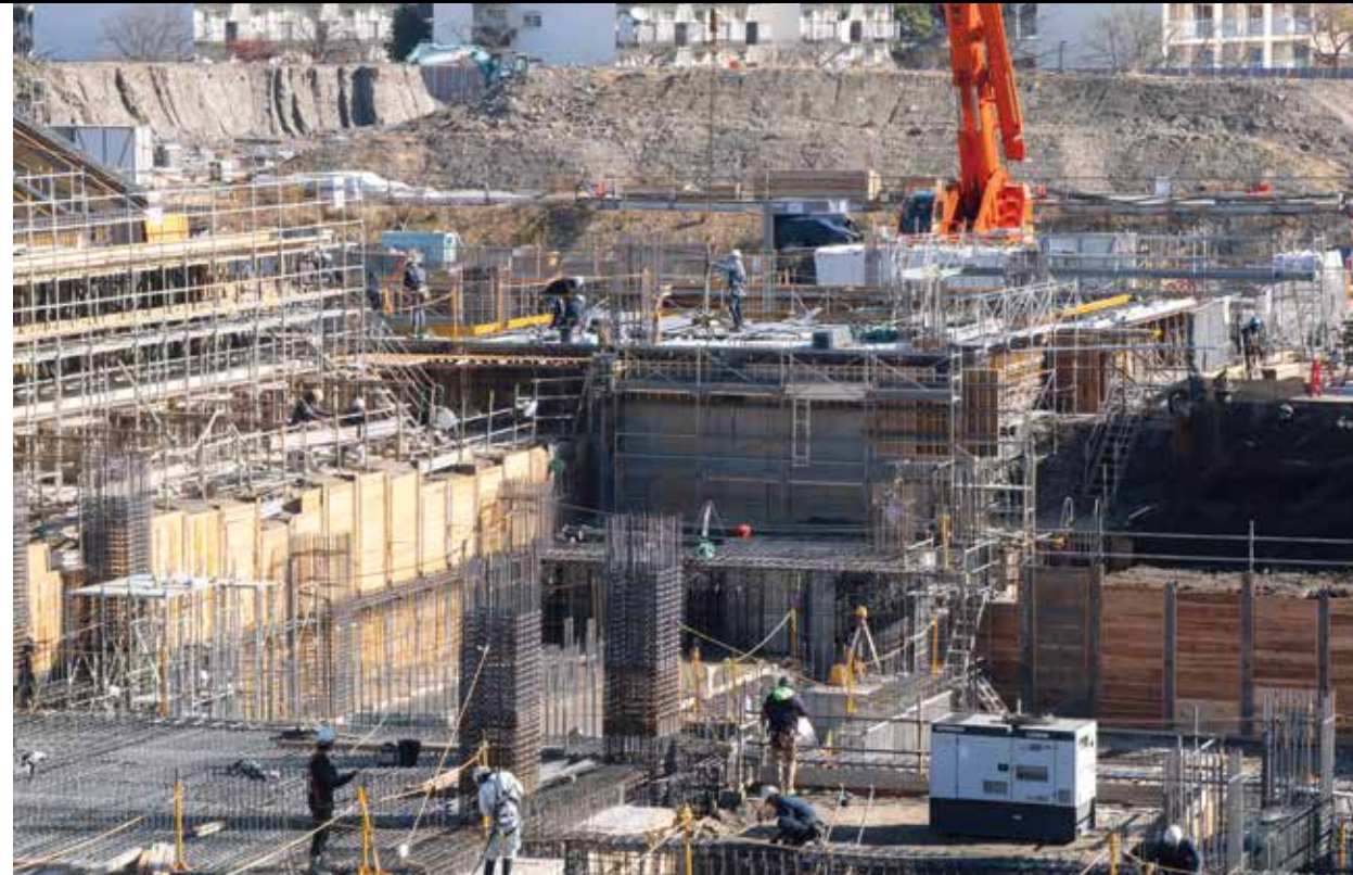
右上・右中/メインプールとサブプールの完成予想図 右下/エントランスには県産の木材を使用する（提供：前田建設工業(株)） 左/プールの施工状況。全20工区に分割し、スライドの進捗に合わせて細かく工程管理されている
