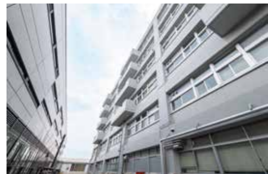
36棟の増築に伴い延焼ラインが変更されたため対面にある26棟の壁面サッシを防火認定品に改修した。狭隘な現場の占有には大学側の全面的な協力があつた
