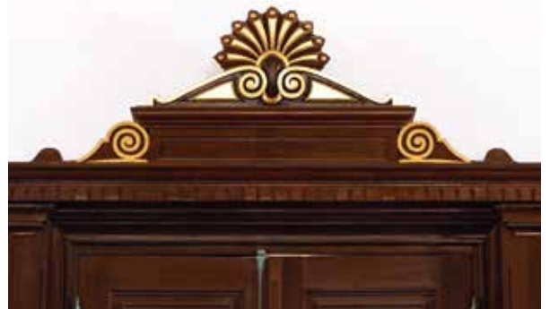
扉の上部を飾る、華やかな金色の扇形装飾が強く目を引く。この旧学習院初等科正堂は、明治期の「擬洋風建築」を代表する貴重な遺構の一つだ。西洋の建築様式を日本の職人が木造で見事に具現化した意匠の美学が、この緻密な装飾に凝縮されている。120余年の時を超えてなお、空間に皇族の学び舎らしい圧倒的な気品と、揺るぎない威厳を添えている。
