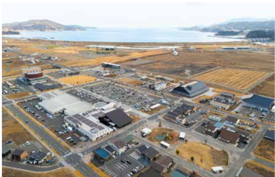
陸前高田市高田町中心市街地の空撮
