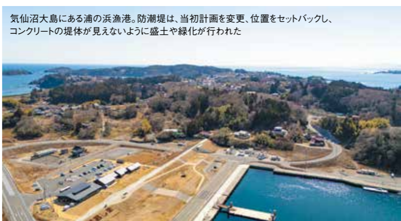
気仙沼大島にある小田の浜(奥)と田中浜(手前)。コンクリートの巨大防潮堤計画を中止し、小田の浜は原型復旧、田中浜は広葉樹を植えた「緑の防潮堤」が造られた
