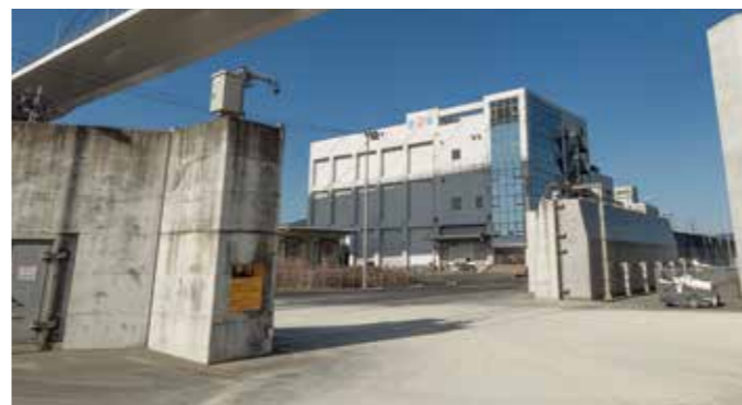
陸間。宮城県の水門、陸間では、津波注意報や津波警報などの発表時に現地でも人が操作することなく、安全かつ迅速、確実に自動閉鎖するシステムを採用している
