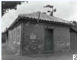
ケーブルハット(海底線陸揚庫)
