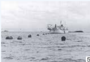
海底ケーブル敷設状況
