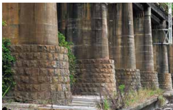
山生橋梁の海側を並走する房州大橋は太平洋の絶景を望むビューポイントとして知られる（上）。山生橋梁の橋脚は満潮時には浸水することから塩害が懸念されたが1980年代の調査では一部に発錆が見られるものの概ねその健全性を保っていると評価された（下）。
