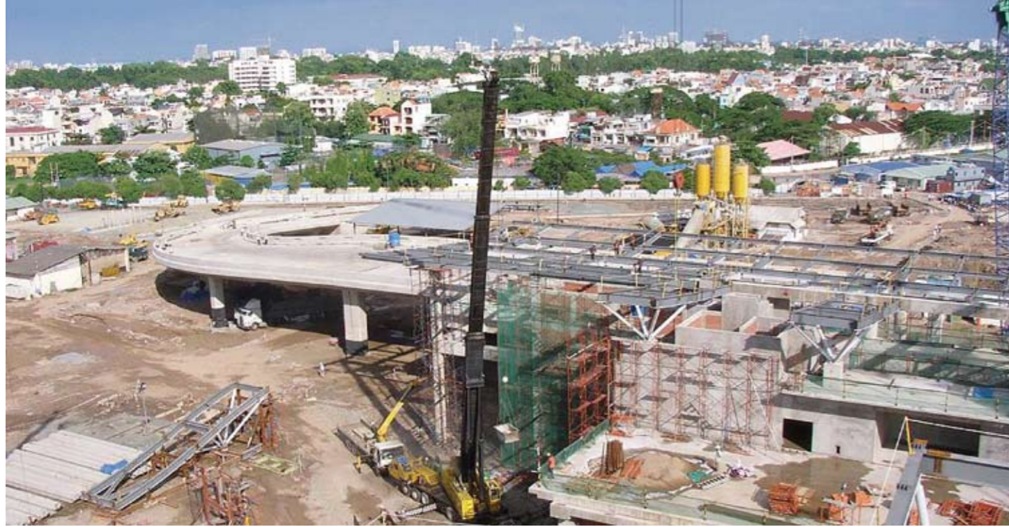
ベトナムホーチミンのタンソンニャット国際空港ターミナルビル工事には、取り付け道路の高架橋などの土木工事も。楓氏が土木屋1人で行って手掛けた。
