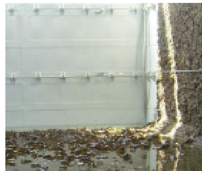
図-1.4.4 塩害による取水設備の劣化事例
