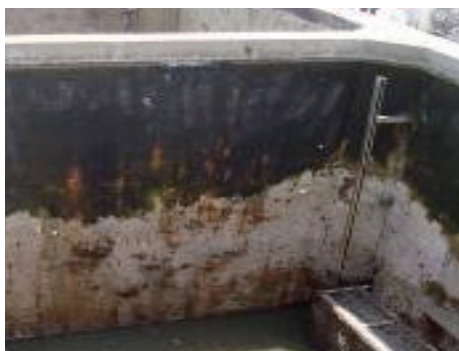
図-1.4.4 塩害による取水設備の劣化事例
