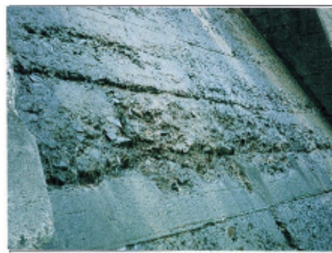
図-1.4.1 凍結融解作用による堤体の劣化事例 5)
