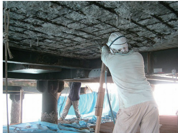
図-3.3.2 床版はつり状況
