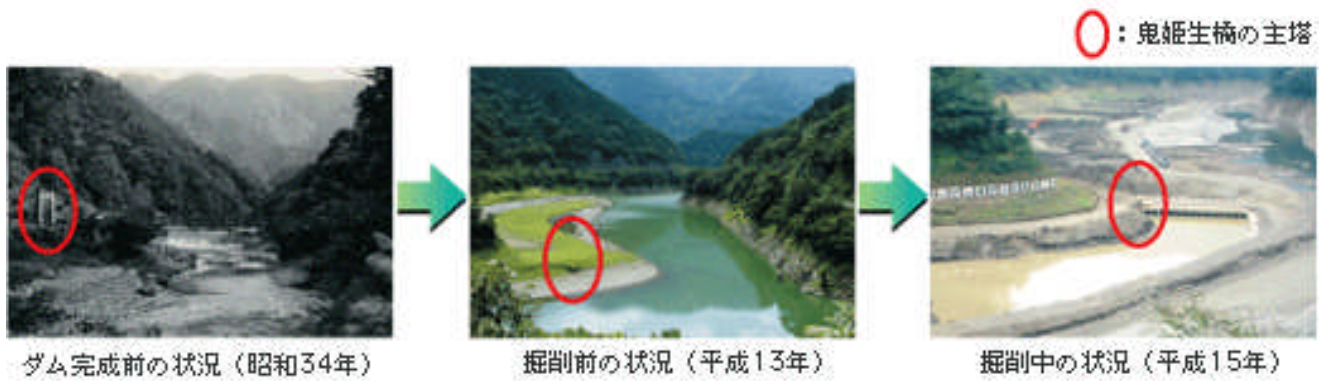
図-1.3.24 ダム貯水池の堆砂状況の移り変わり 9)
