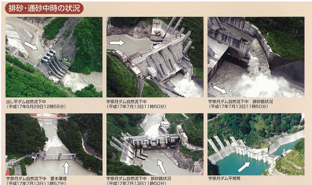
図-1.3.14 排砂・通砂中の状況写真 29)
