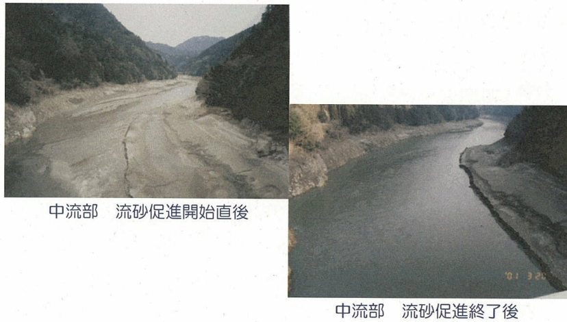
図-1.3.19 流砂促進前と終了後の状況 8)
