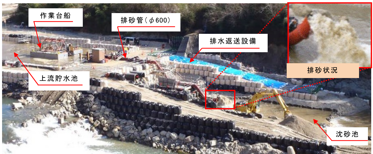
図-1.5.13 実験状況全景
