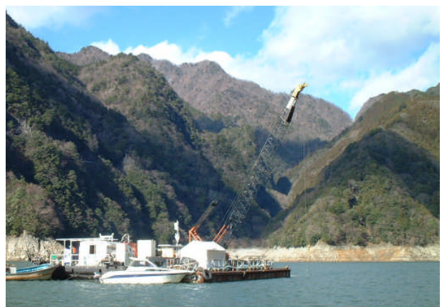
図-1.5.5 Hydro-J工法稼働状況 32)
