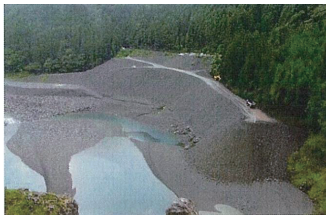
図-1.6.8 那珂川における大規模置き土状況 53)
