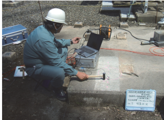
探査状況(変電所設備基礎杭)
