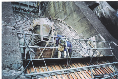
写真 補修工事状況
