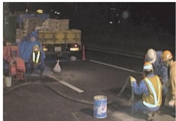
道路下への適用事例； 下水道施設改修工事として、空洞
