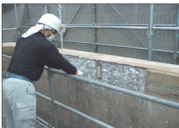
断面修復 (犠牲陽極材取付)
