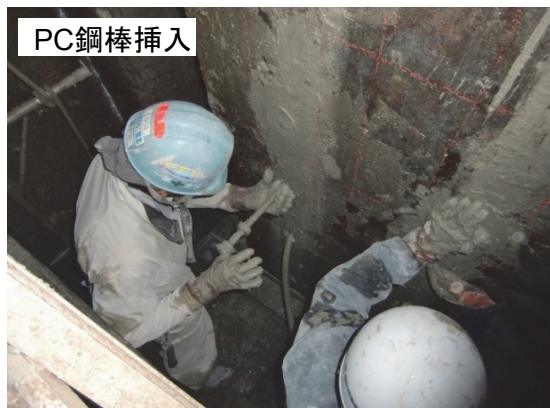
適用工事での施工状況
