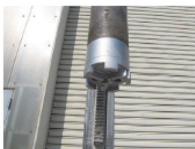
削孔先端の処理
