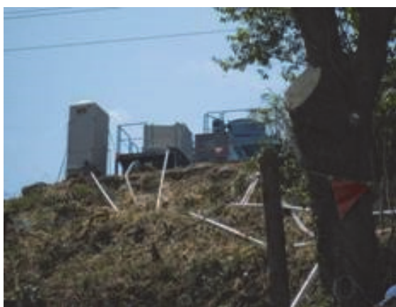
法面部配管状況
