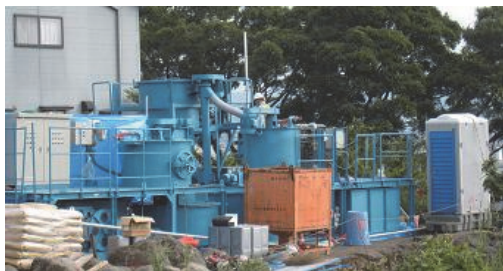
ミキサー、およびポンプ設置状況
