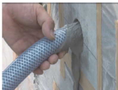
グラウト材の注入
