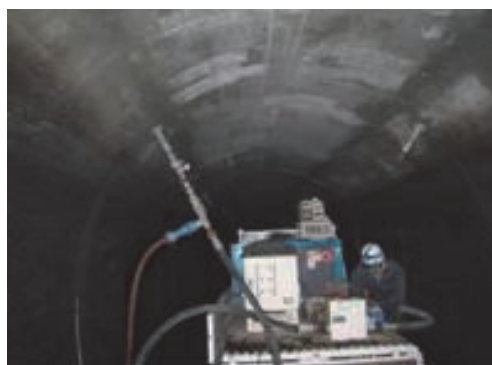
充填作業状況
