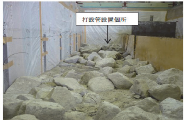
間隙充填用水中不分離モルタルの充填状況
