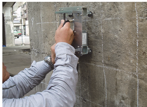
写真3 打音調査・診断システムの適用(高架橋柱)
