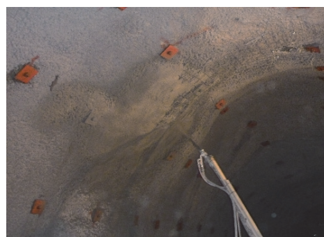
鉱山作業通路補修
