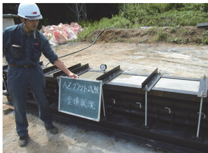
充填性能試験
