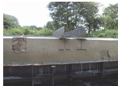
角材、H 鋼周りの充填状況
