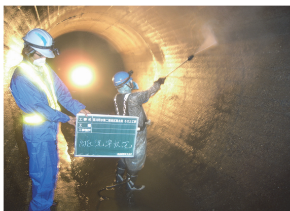
写真-2 洗浄工施工状況
