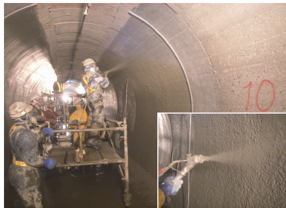
写真-4 PCM吹付け状況
