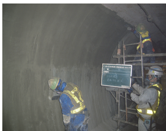
写真-5 PCMコテ塗り状況
