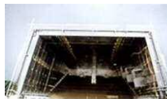
仮締切上部から見た状況
