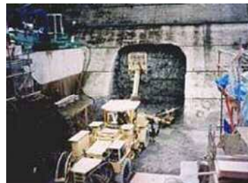
スロット穿孔状況
