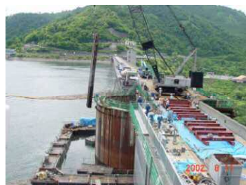
仮締切撤去状況
