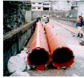
鋼管杭先端状況
