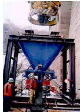
コンクリート打設状況
