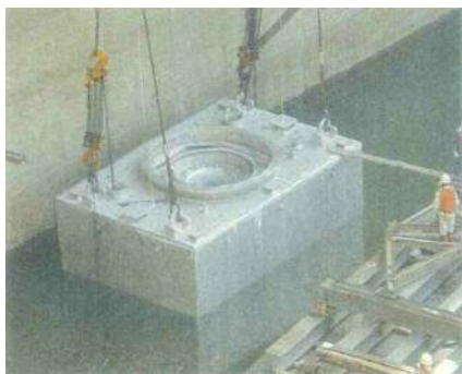
(a) チャンバー吊込み状況
