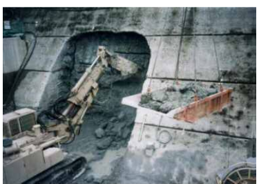
ブレイカー掘削状況
