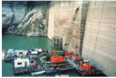
鋼管杭打設状況
