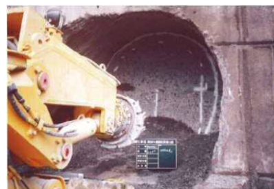
ロードヘッダによる切削状況
