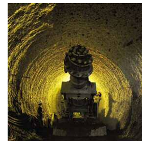
ロードヘッダと坑壁状況
