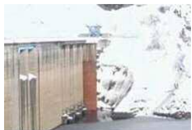
仮締切完成状況
