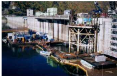
仮締切導枠設置状況
