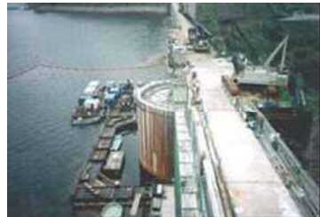
仮締切施工状況
