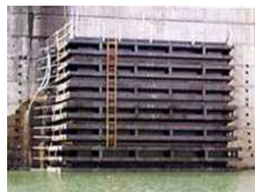
仮締切正面から見た状況
