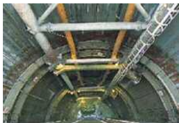
仮締切内部状況
