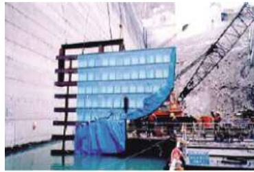
大型型枠設置状況
