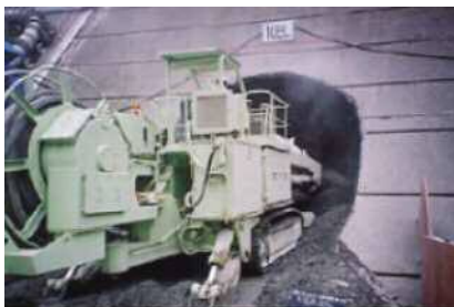
ロードヘッダ掘削状況
