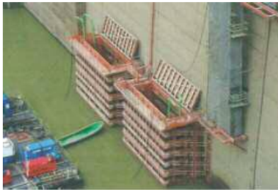
仮締切設置状況
