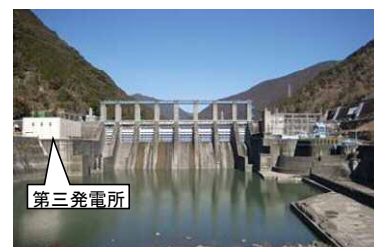
図-① 秋葉第三発電所現況
