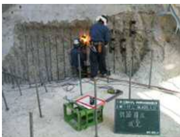
鉄筋圧接状況
