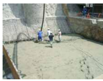
コンクリート打設状況
