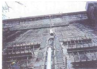
⑦ 堤体背面部導水管吊込み状況
