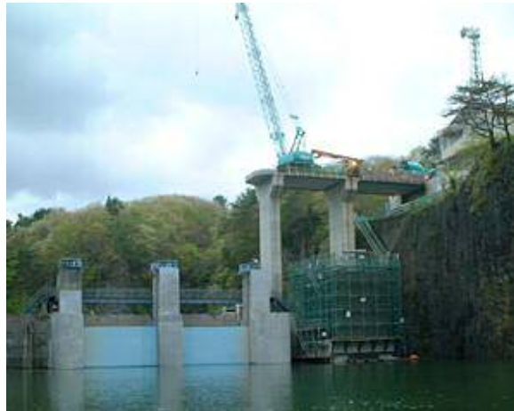
新設取水塔工事状況 2)
