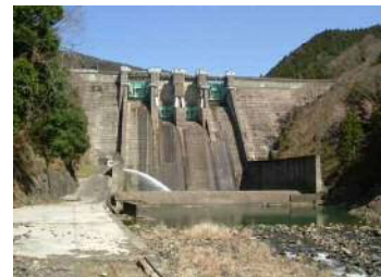
⑧ 取水放流設備完成状況 (堤体下流)
