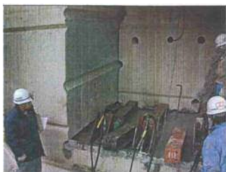
④ 油圧ジャッキによる押し出し (2ブロック目以降)
