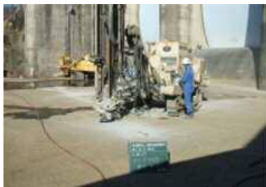
ラインドリリング状況
