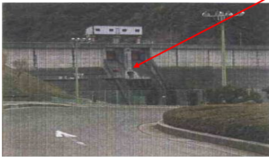
工事完了全景
