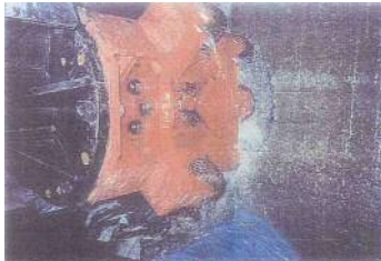
⑤ リーミング掘削開始状況
