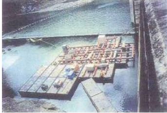
② 取水管組立架台(ユニフロート)設置状況
