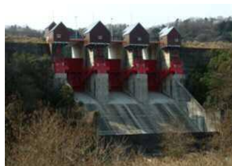
完成下流から
