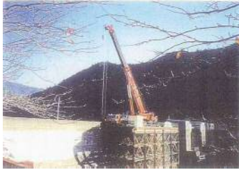
① 堤体下部作業構台設置状況
