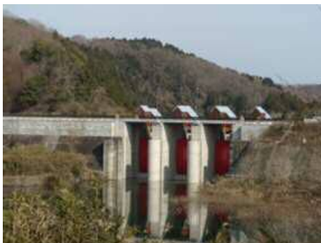
完成上流から
