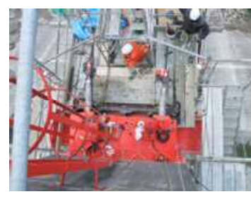
アンカー設置状況
