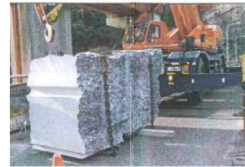
⑧ 割裂ブロック撤去
