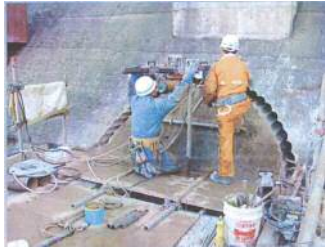
① 水平コアボーリング施工状況
