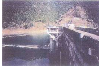
③ 取水管据付完了状況
