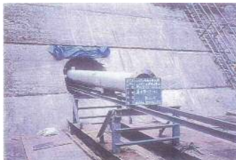
⑥ 導水管引込み状況
