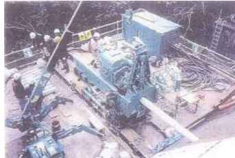
④ パイロット孔の削孔
