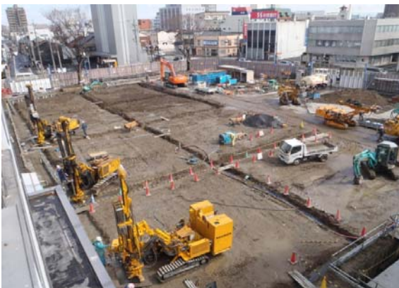
写真4 2012年3月 仮設遮水先行削孔状況
