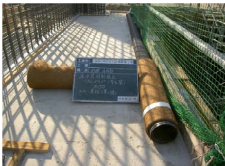
写真5 透水管 TAC パイプ（有孔管）φ150
