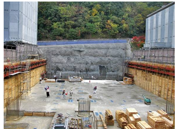
写真-10 全体掘削完了状況
