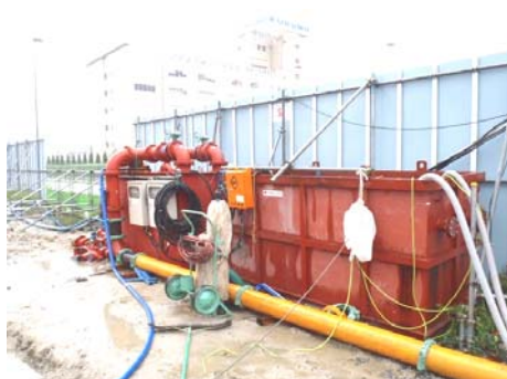
写真3 ノッチタンク設置状況
