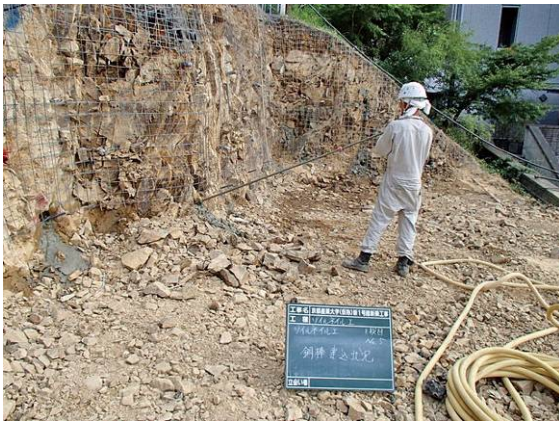
写真-7 ⑤ネイル設置・養生・締付け
