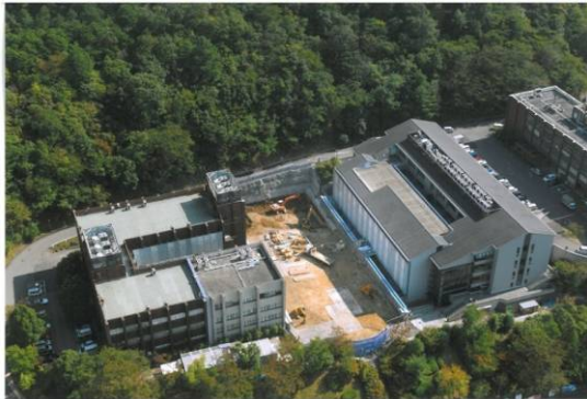
写真-1 地下躯体施工時周辺状況
