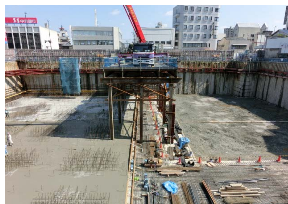
写真8 2012年9月 全面床付状況
