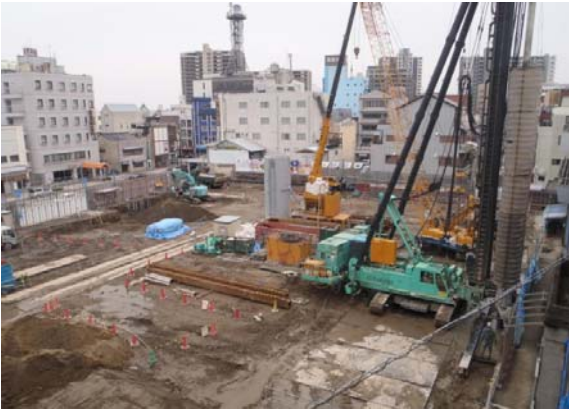
写真3 2012年2月 SMWの構築状況
