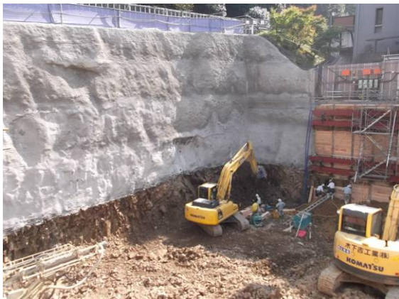
写真-9 5次掘削実施状況
