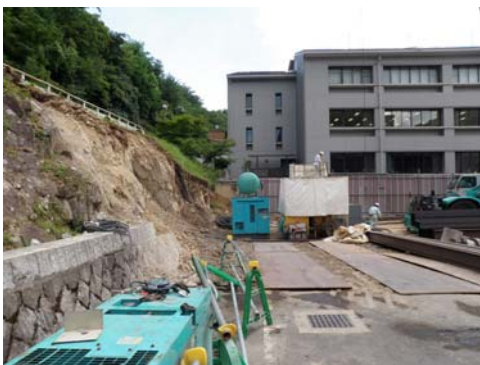
写真-2 山留施工前の地盤状況
