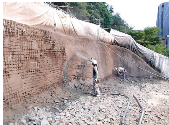
写真-8 ⑥モルタル吹付け
