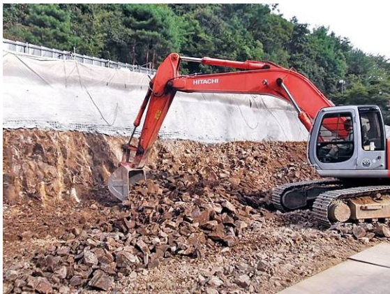
写真-3 ①掘削(1次掘削実施状況)
