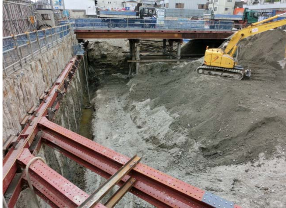
写真6 2012年7月 1次根切状況
