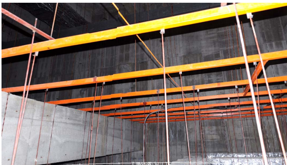
写真6 点検口からの撮影状況 (CL+1500 mm程度)
