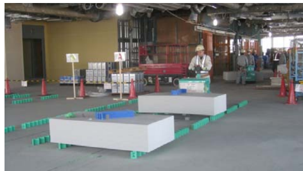
写真4 低層用EVからの荷降ろし
