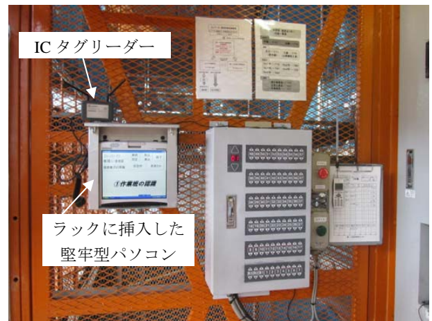
写真1 工所用EV搬機の状況
