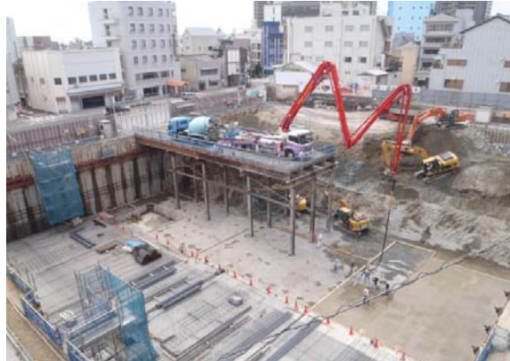
写真7 2012年8月 2次根切状況
