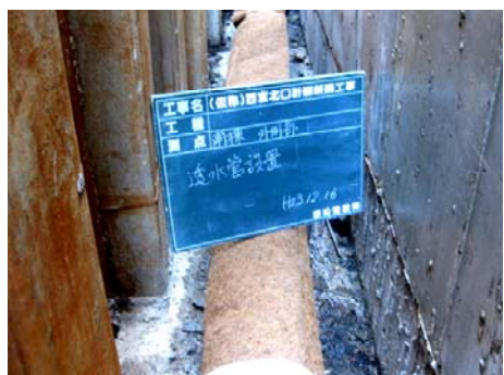
写真6 透水管設置状況
