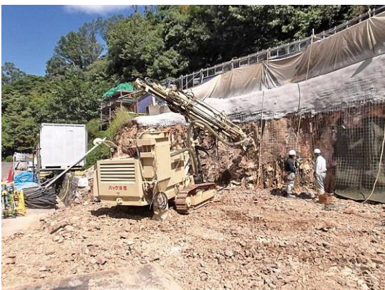
写真-5 ③削孔
