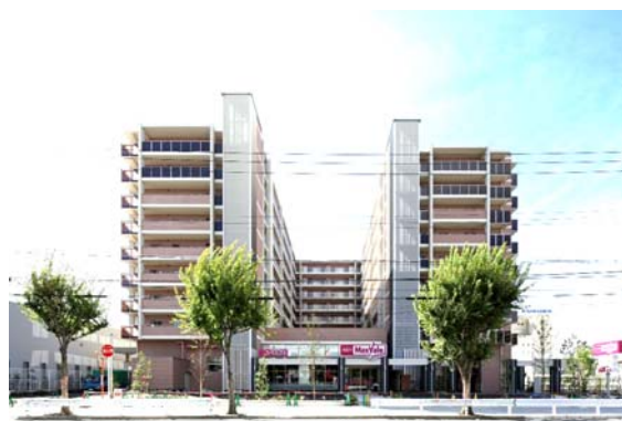
写真1 竣工写真(北側外観)
