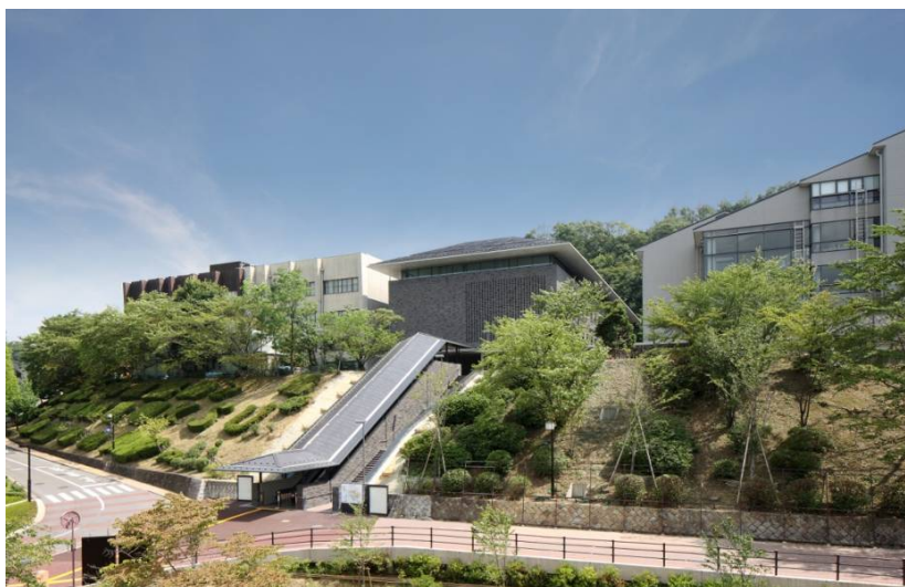
写真-11 エスカレーター下からの西面全景写真
