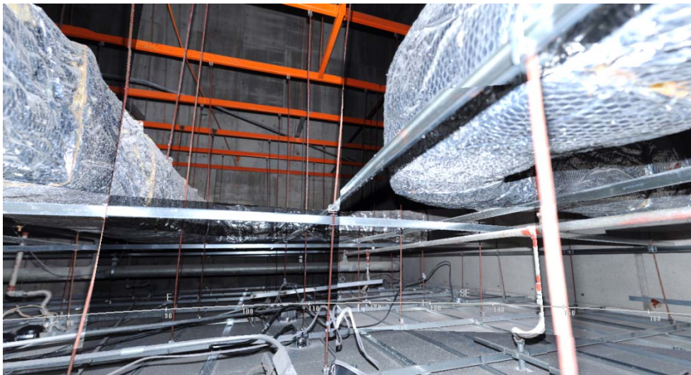
写真5 点検口からの撮影状況 (CL+500 mm程度)
