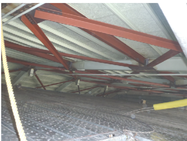
写真5 新設梁及び新設ブレース取付状況
