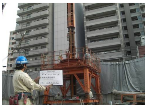
写真-4 構真柱建入れ状況
