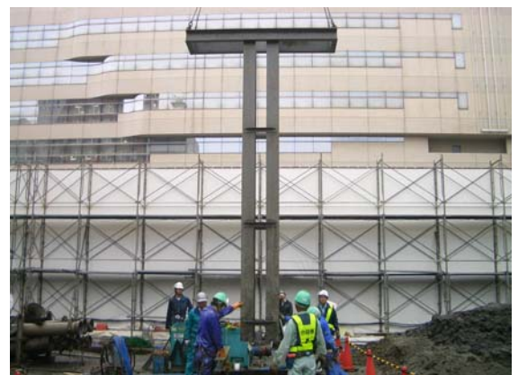
写真-5 仮支柱治具の設置状況
