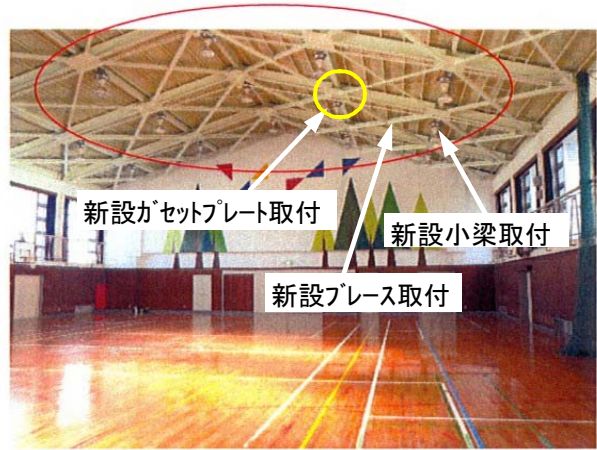
写真2 耐震補強改修後の鉄骨屋根組状況
