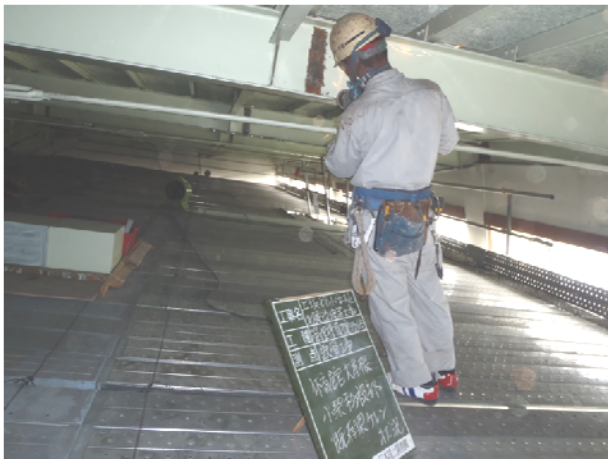
写真3 新設ガセットプレート取付部ケレン状況
