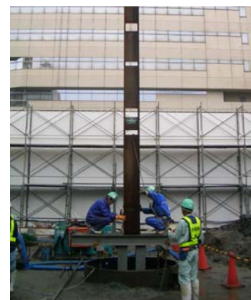
写真-6 仮支柱建込み状況
