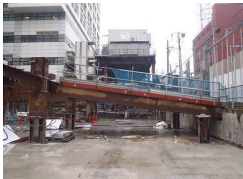
写真-1 仮設スロープ構台
