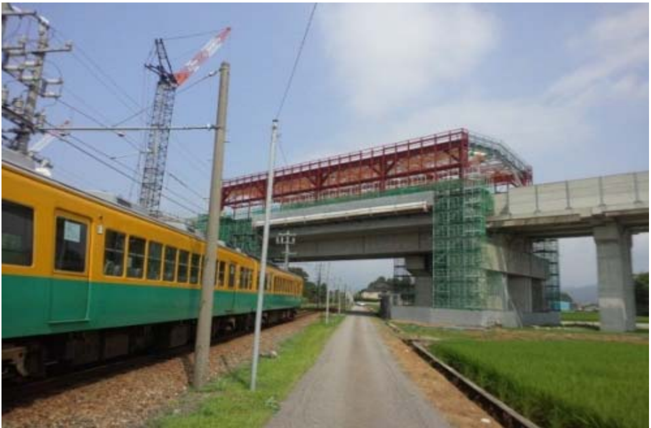
写真-11 トラベリング架構の直下を通過する営業線
