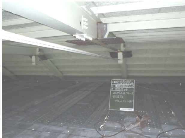
写真4 新設ガセットプレート取付状況
