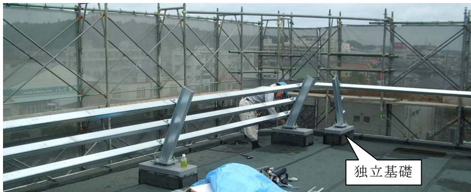
写真1 鉄骨下地取付状況
