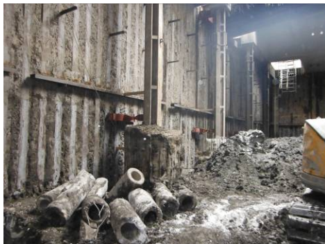
写真-6 溝形鋼による山留め壁補強状況
