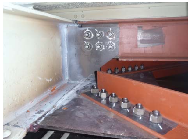
写真6 本締め完了状況
