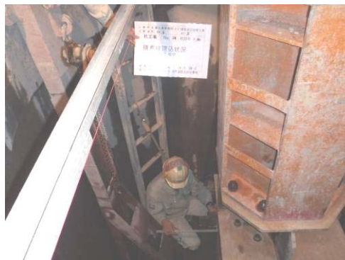
写真-5 構真柱建込み確認状況
