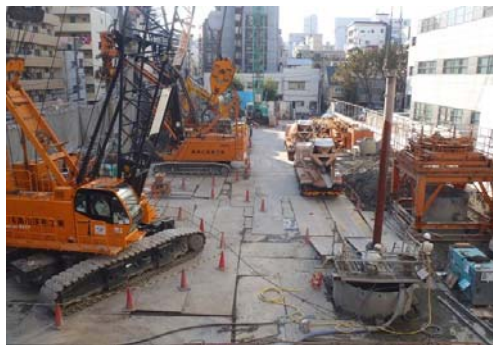
写真-3 構真柱施工状況
