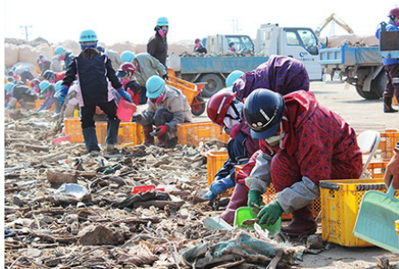
写真 4.1 二次仮置場 手作業による選別
