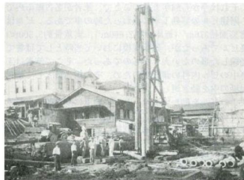
写真 3.2.7 東京物理学校第一号館の基礎杭工事 33)
