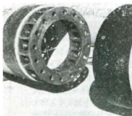
写真 3.2.10 ボルト式継手 33)
