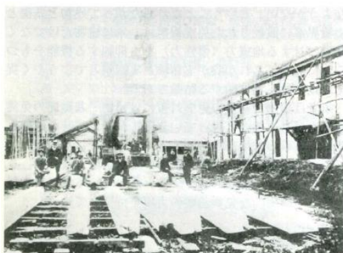
写真 3.2.6 築地海軍造兵廠材料倉庫での杭打ち工事 33)
