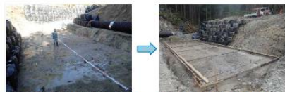
基礎地盤（立会確認）
