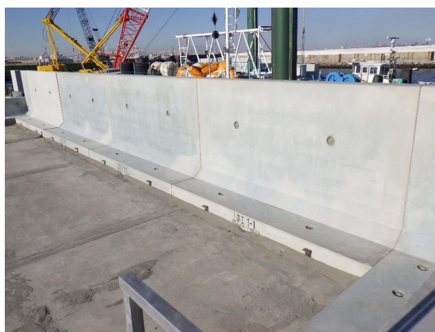
写真 設置完了時
