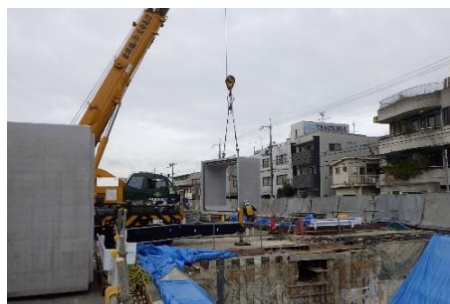
プレキャスト部材搬入状況
