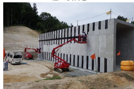
組立状況②
