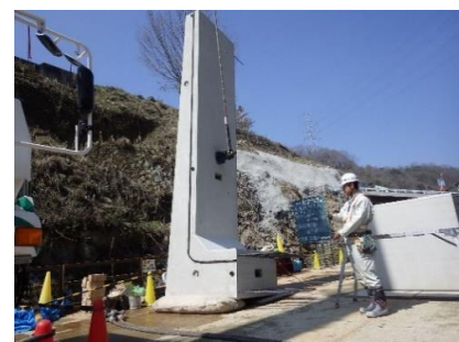
プレキャスト擁壁搬入状況
