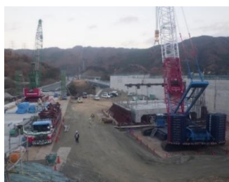
全体施工状況
