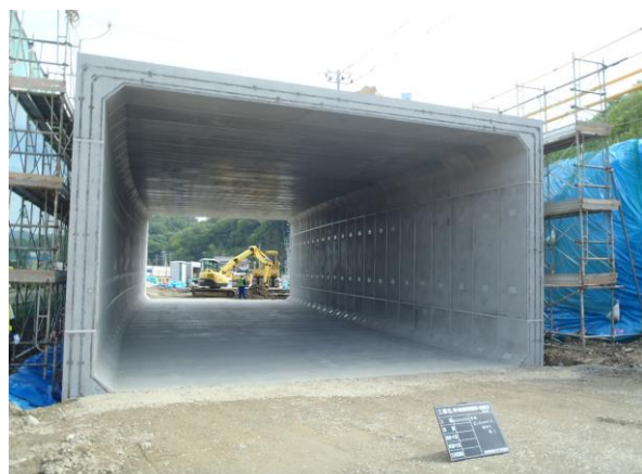
ボックスカルバート敷設完了
