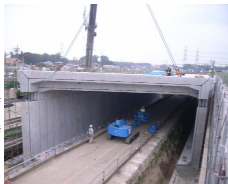
写真-プレキャスト部材架設状況
