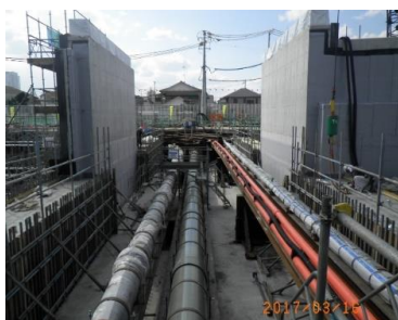
台座コンクリート施工
