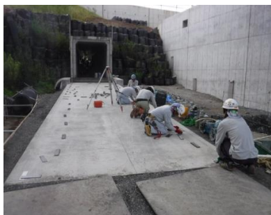
プレキャスト据付準備
