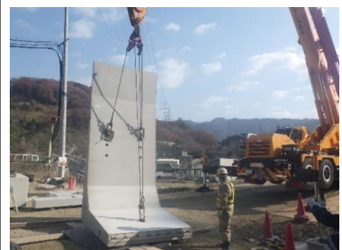
L型擁壁据付状況
