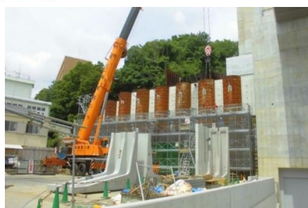
プレキャスト部材据付
