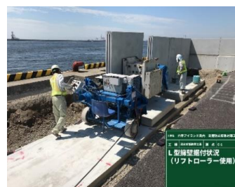
据付状況 (リフトローラー使用)
