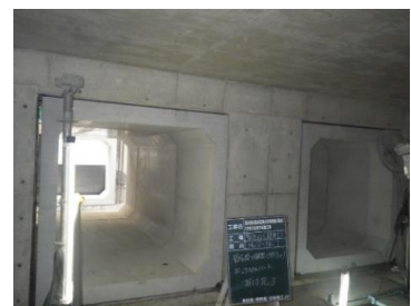
据付完了（躯体内）
