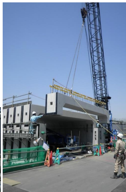
プレキャスト部材据付
