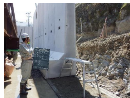
プレキャスト擁壁据付状況
