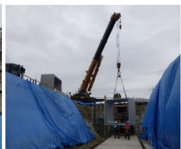
プレキャスト部材設置状況
