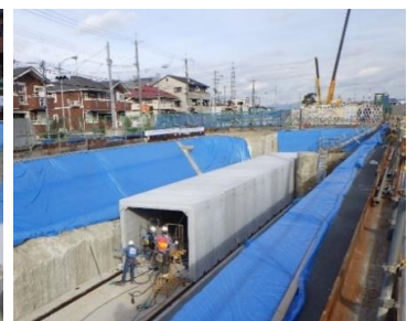
プレキャスト部材設置完了
