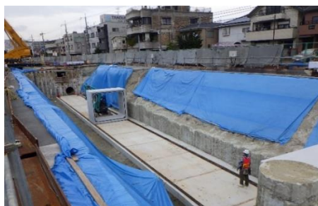
プレキャスト部材横引状況
