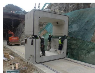
上部材設置状況
