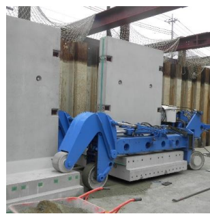
中央壁タイプ(据付状況)
