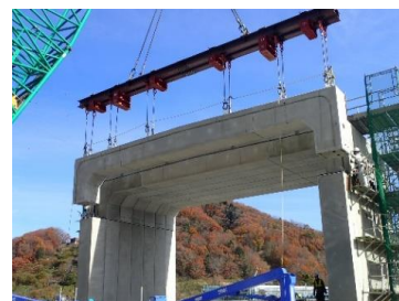
上部材設置状況
