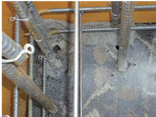
写真1 アンカー打設削孔状況
