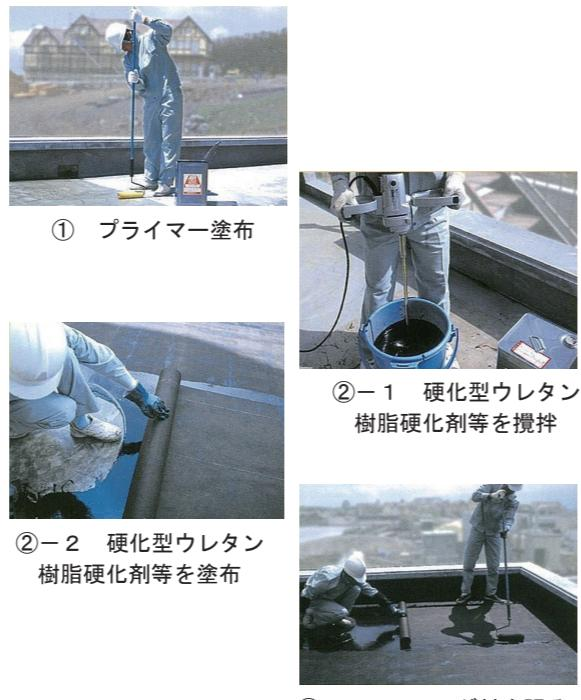
写真1 改質アスファルト防水常温工法施工手順<sup>1)</sup>
