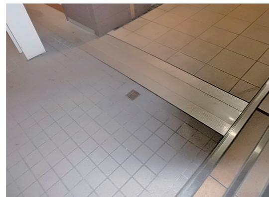
写真1 排水口取付処置後
