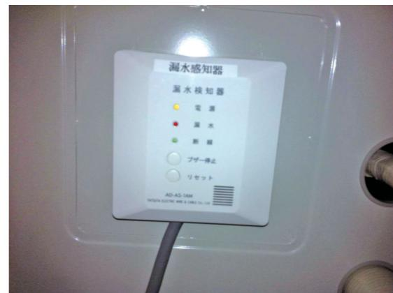
写真3 漏水検知器（本体）
