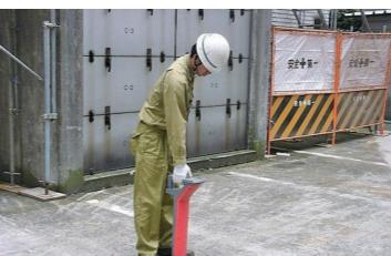
写真3 鉄管・ケーブル探知機による埋設物探査状況
