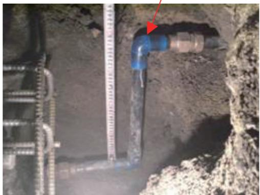
写真2 埋設給水配管
