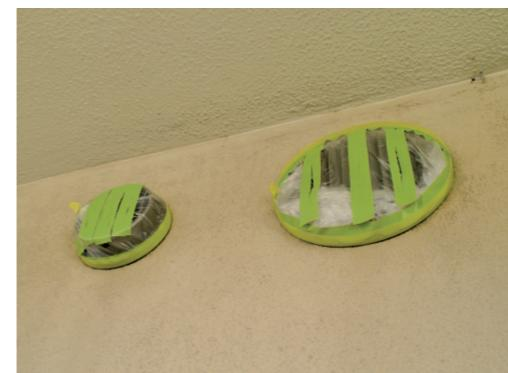
写真1 給気口養生状況
