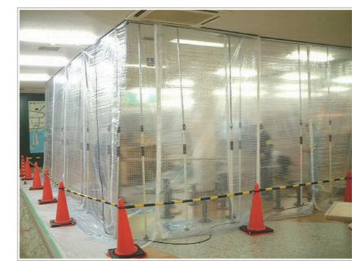
写真2 ホコリ飛散防止シート<sup>1)</sup>
