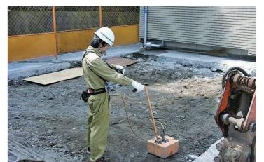
写真5 近・中距離対応型レーダーによる埋設物探査状況
