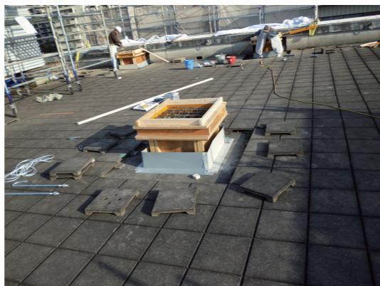
写真2 屋上設備基礎施工状況
