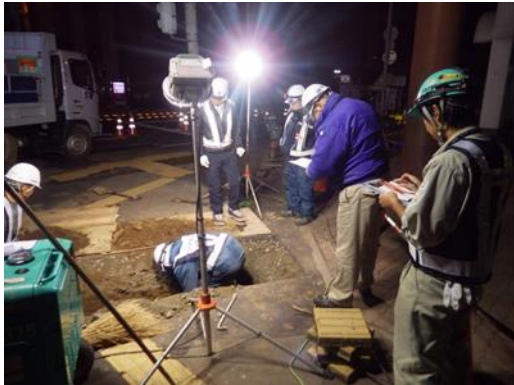
手掘りによる掘削の範囲
