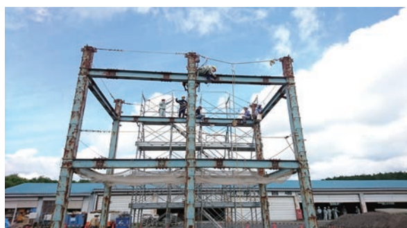
鉄骨建て方実習
