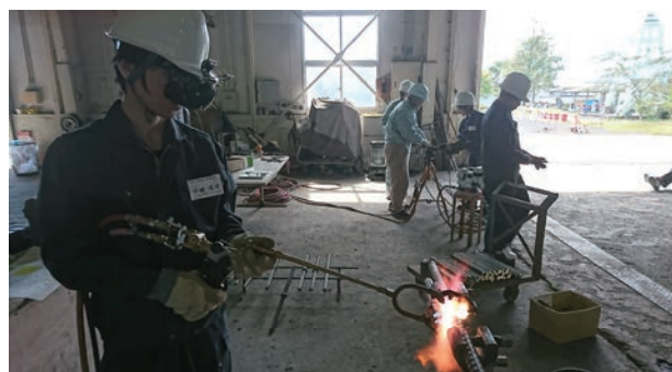
鉄筋圧接実習
