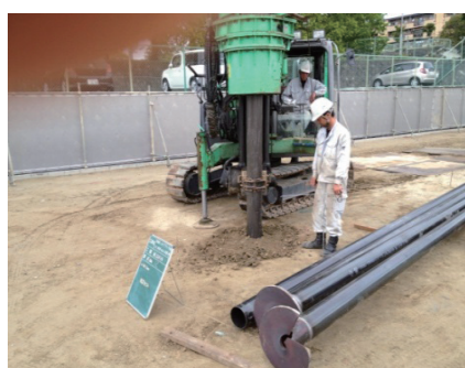
鋼管杭施工状況 1)
