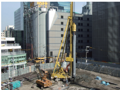
場所打ちコンクリート杭施工状況
