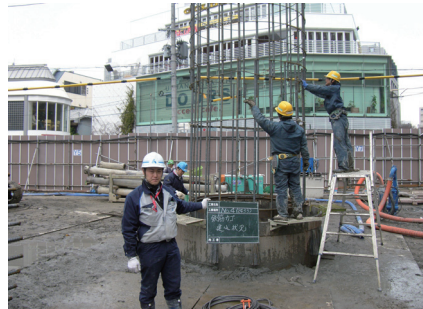
鉄筋かご建込状況
