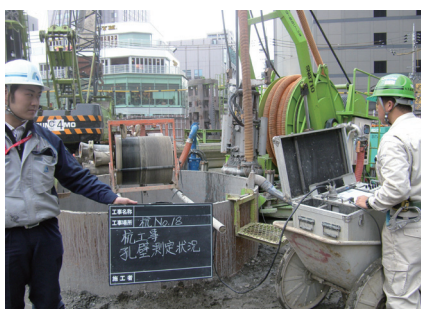
孔壁測定状況
