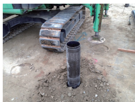
鋼管杭施工完了 1)
