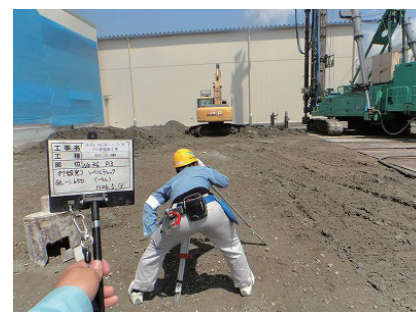
PHC杭レベル確認
