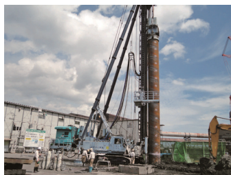
先端拡大根固め工法施工状況
