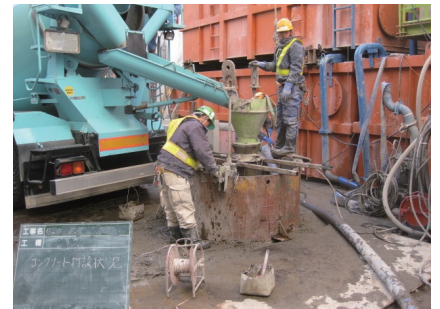
コンクリート打設状況
