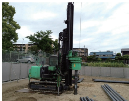
鋼管杭施工状況 1)
