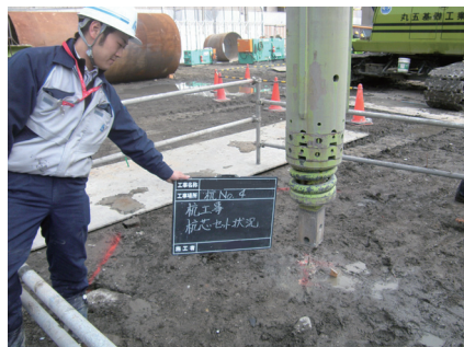
杭芯セット状況
