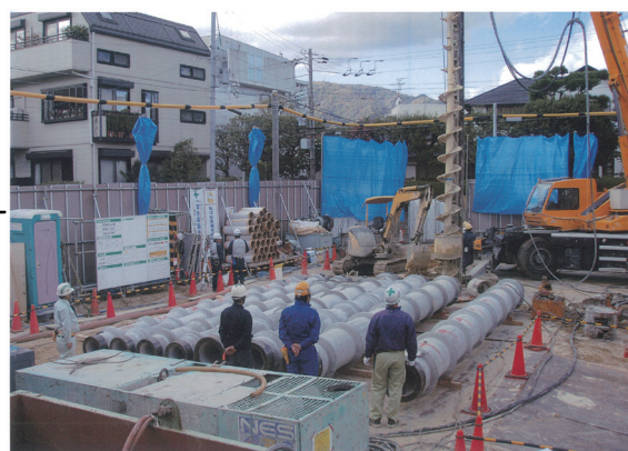
飛散養生実施状況
