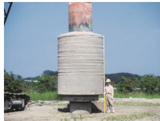
先端拡大根固め部写真
