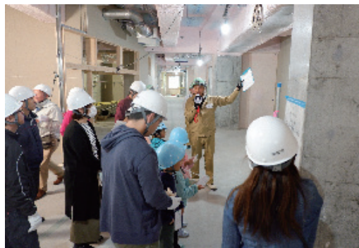
新設小学校現場見学会の実施
