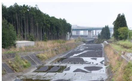
川沿いの樹林により、洪水時に流木や土砂等が背後の家屋や農地等に流入する被害を防止(水害防備林)
