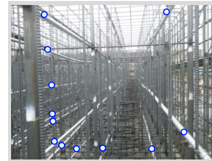
コンクリート打設前(鉄筋組立・パイプ設置完了) ○:鉄筋の間に設置されたクーリング用パイプ
