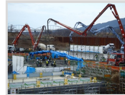
コンクリート打設
